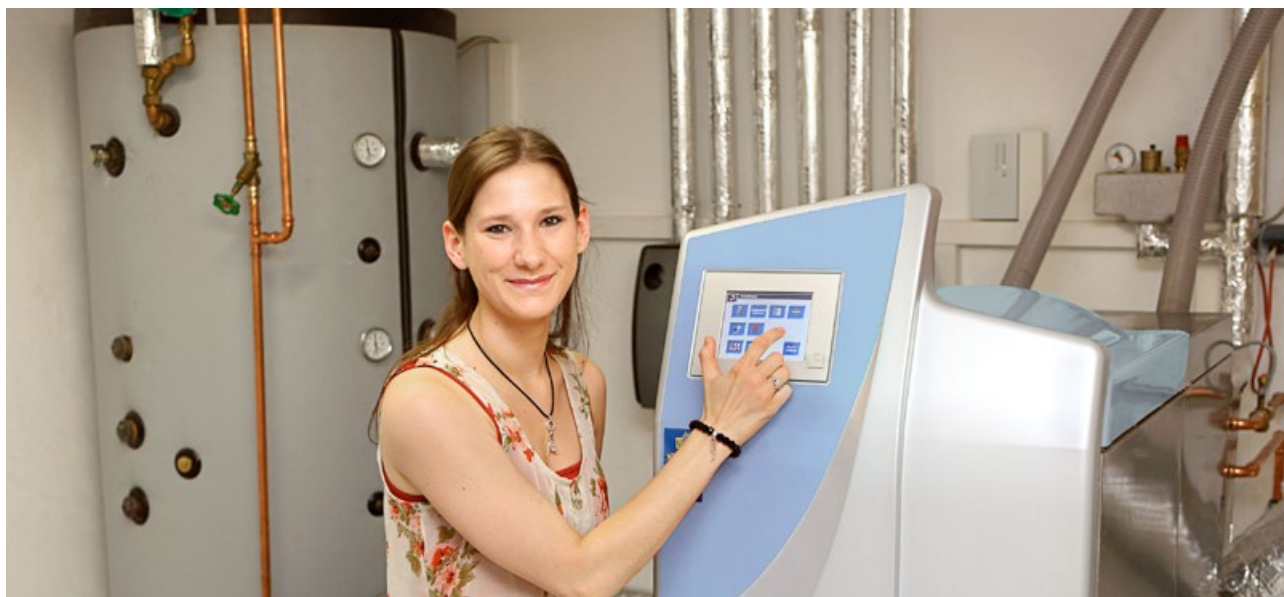
Moderne Holzfeuerungen sind nicht nur äußerst effizient und wartungsarm. Sie lassen sich auch ganz einfach steuern
