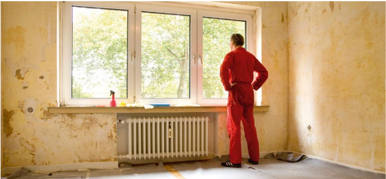
45 Prozent Zuschuss gibt es, wenn die alte Ölheizung durch eine moderne Holz- oder Pelletfeuerung ersetzt wird
