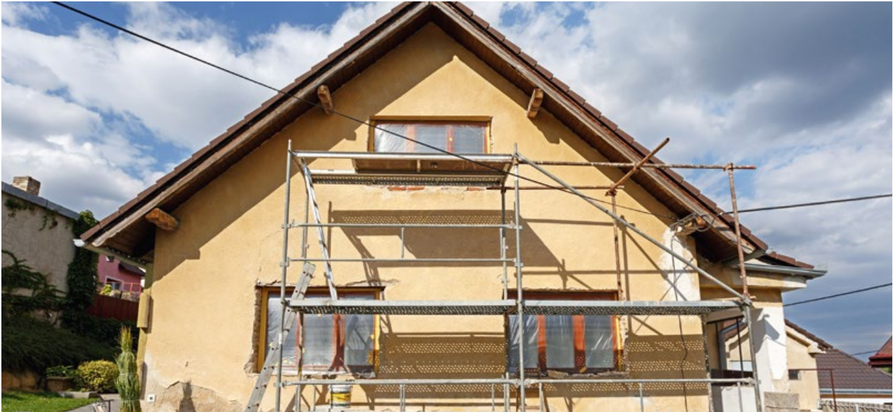
Eine Steuerförderung für den Heizungstausch lohnt sich nur, wenn ein BEG-Förderantrag nicht (mehr) gestellt werden kann
